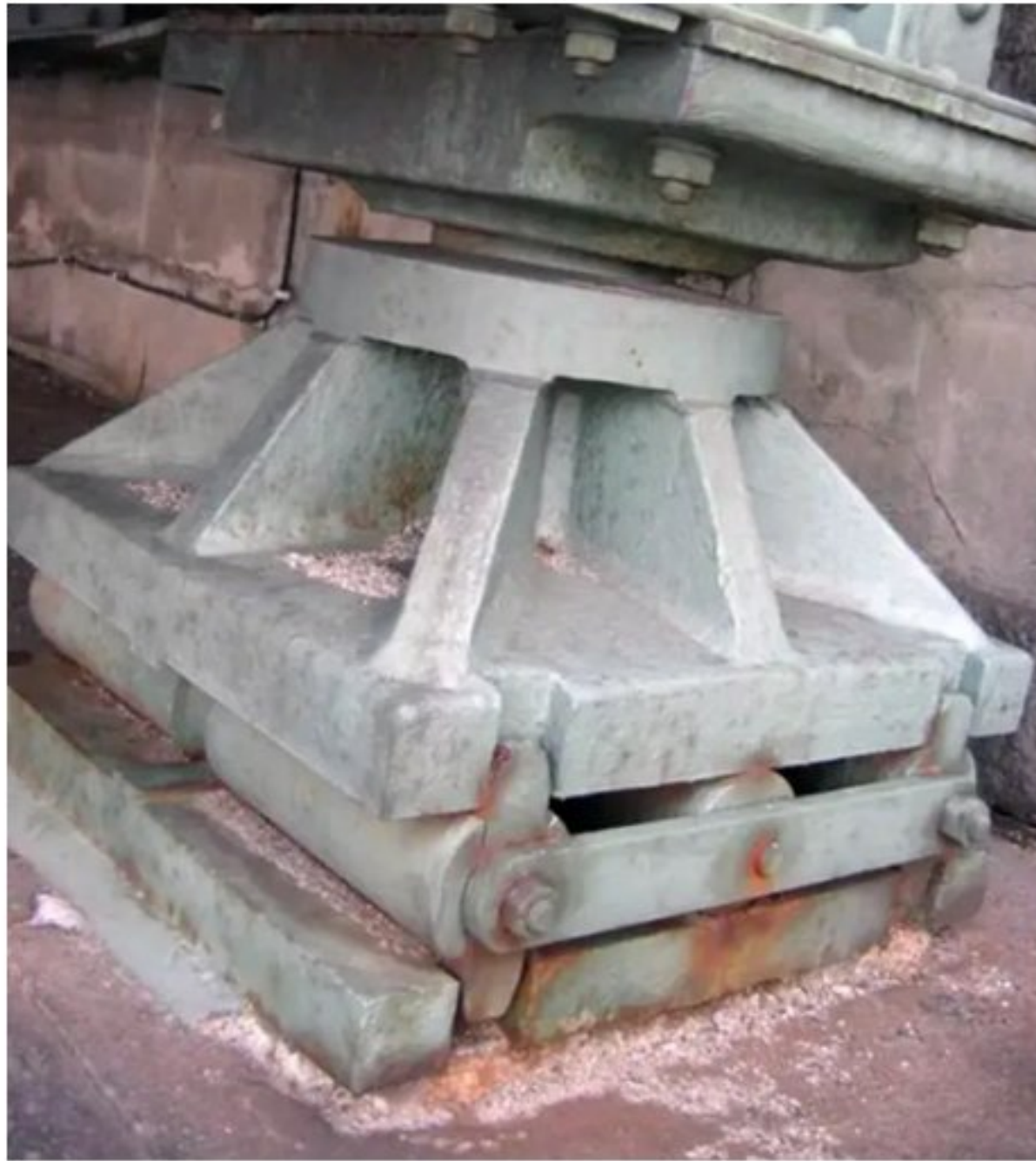
Tipo de Apoyo con libertad traslacional y giro
